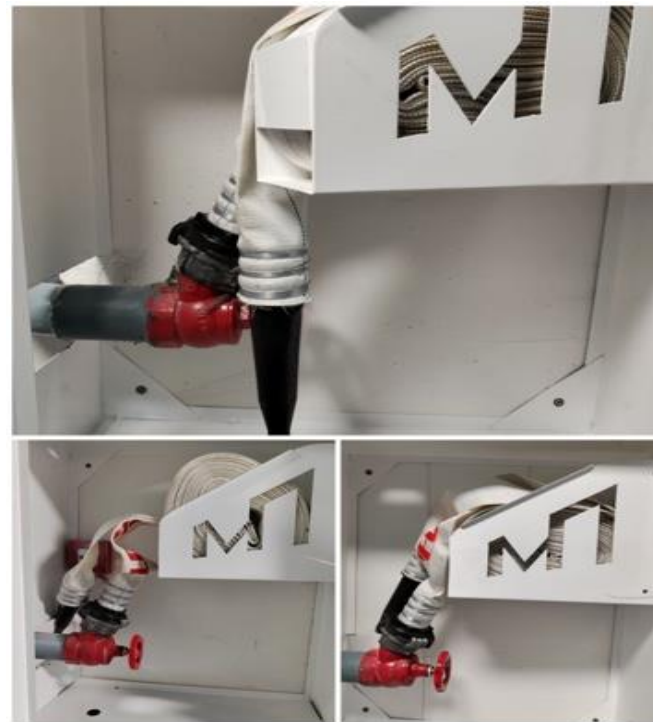
Проверка и раскатка пожарных рукавов по адресу: ул. Дыбенко, д. 4, корп. 1
