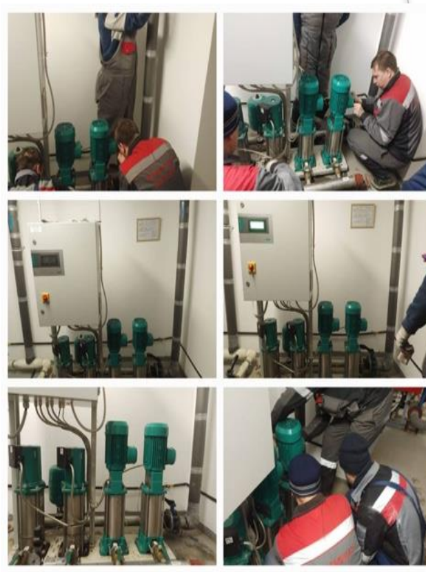
Замена пусконаладочных насосов
